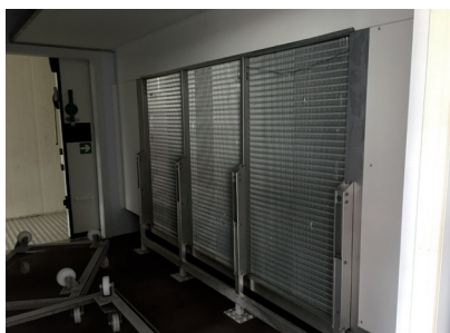
Abb.3: Innerhalb der Anlage / Verdampfer
