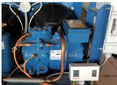
Abb. 2: Kompressor / Verflüssiger
